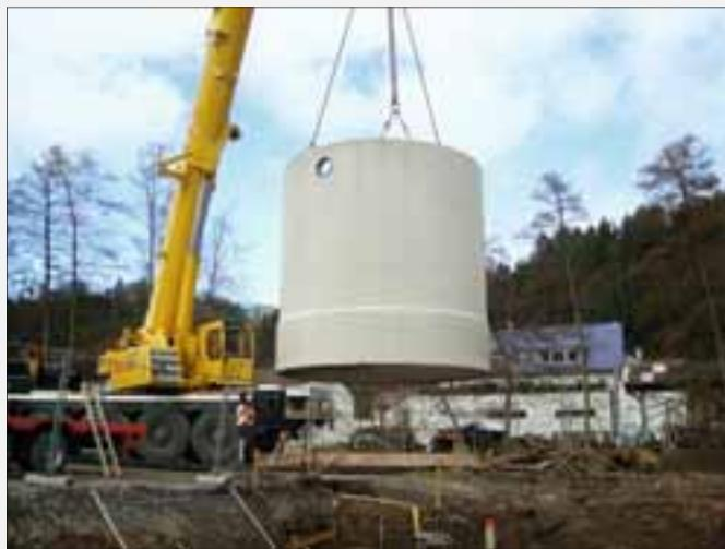
Beim Neubau der Fertigungshalle Talstr. 14 im Werk Nagold wurde eine Zisterne eingebaut. Die Toilettenanlage und die wasserintensiven Waschmaschinen der Triebwerksmontage werden seit der Inbetriebnahme mit Regenwasser betrieben.
